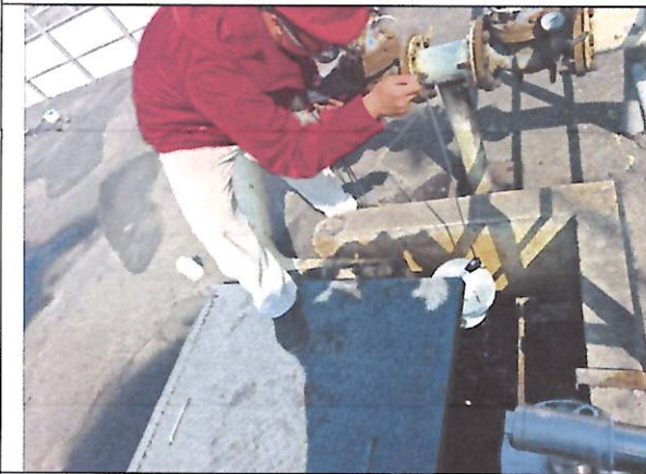
W3 生产污水处理站
