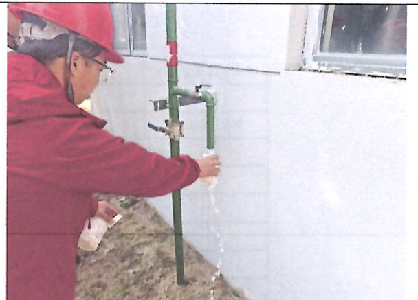
W2 油污水处理站
